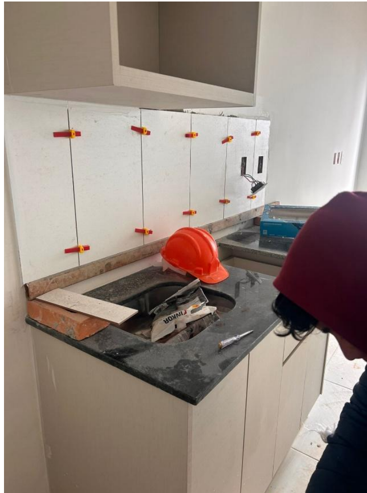
INSTALACION DE MESADA Y AZULEJO COCINA
