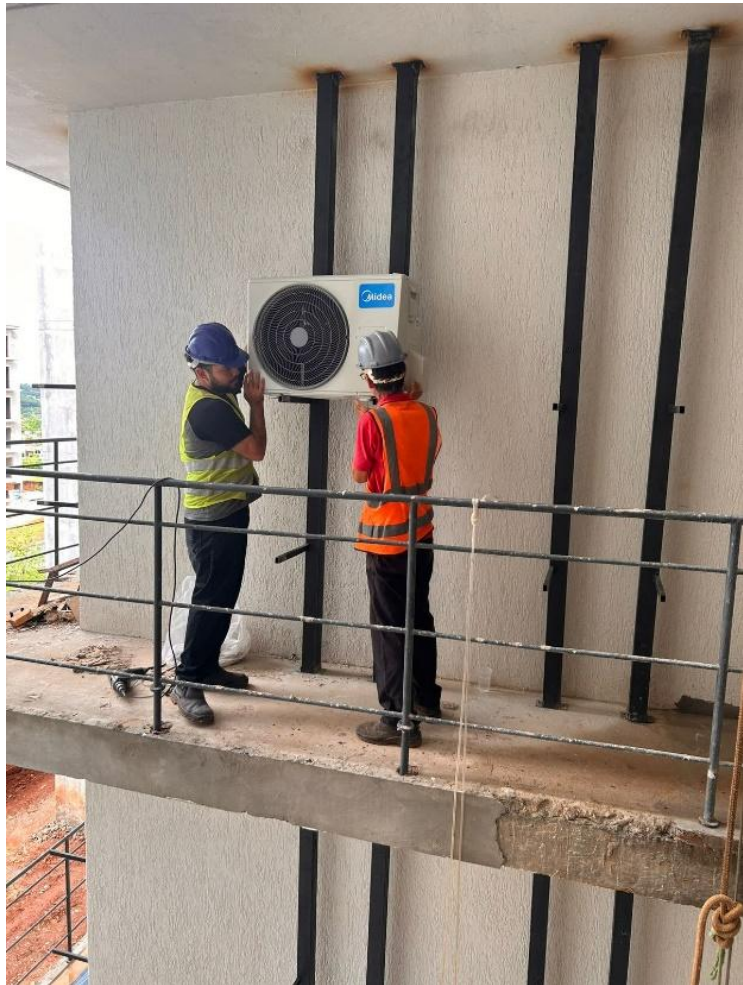
INSTALACION DE COMPRESORES DE AA
